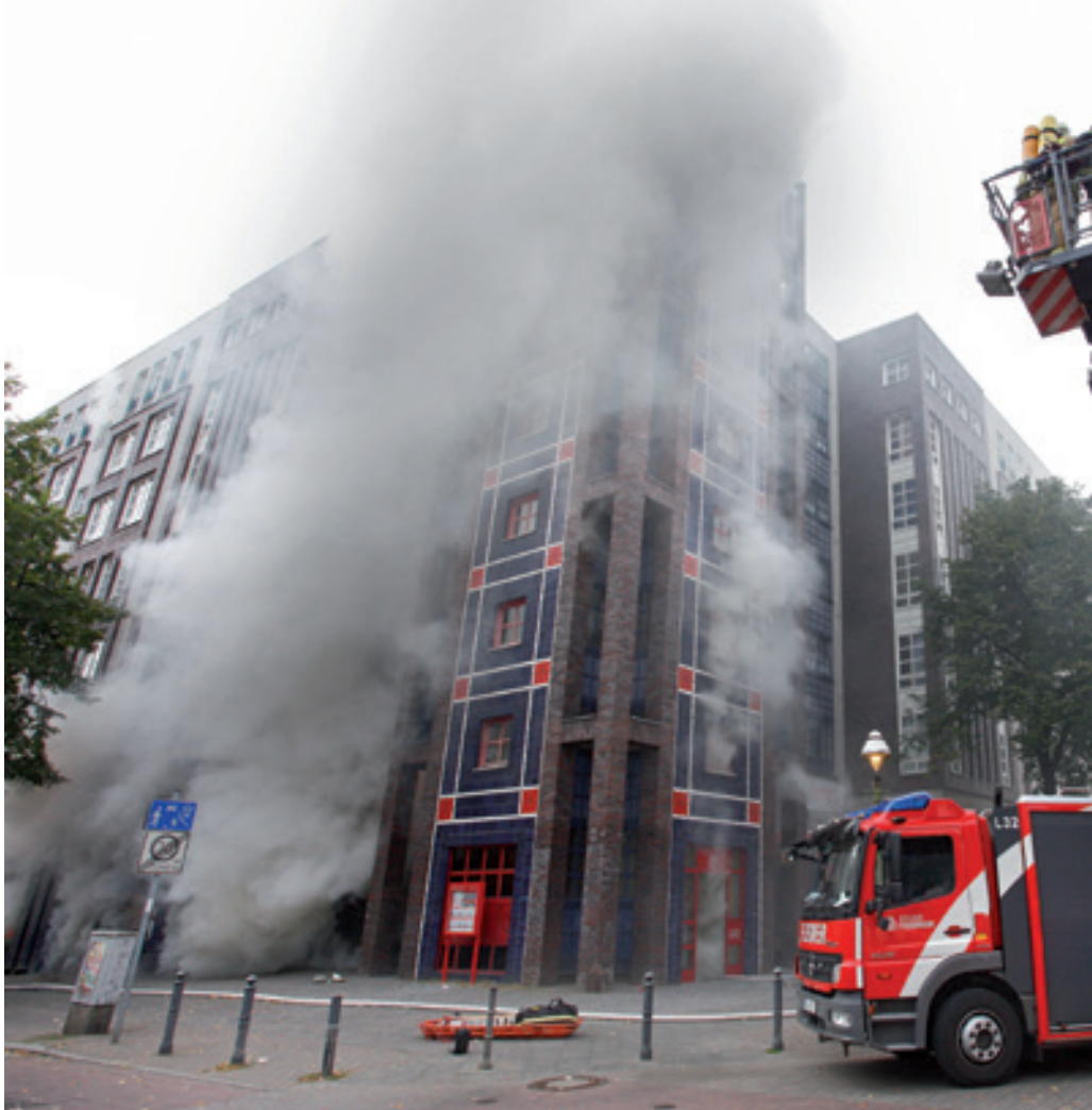
Starke Rauchentwicklung beim Kellerbrand. Der Treppenraum wirkte dabei wie ein Kamin.
