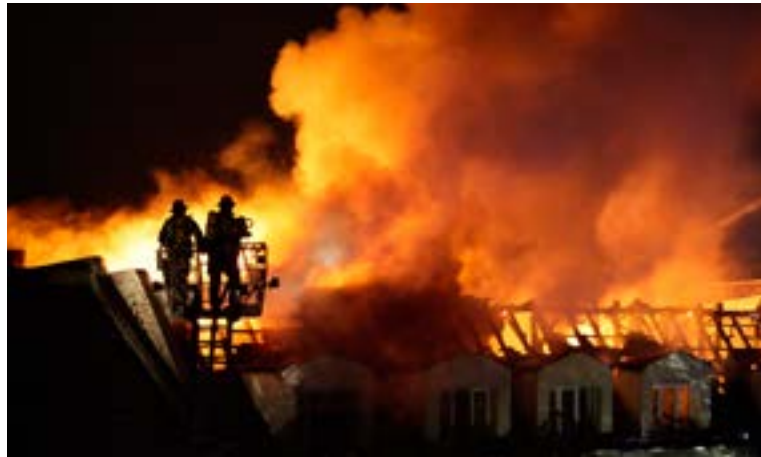
Der Dachstuhl brennt in ganzer Ausdehnung
